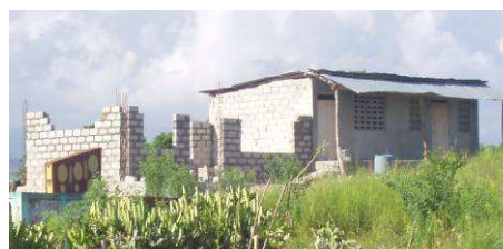
Été 2008 : construction de la deuxième classe
