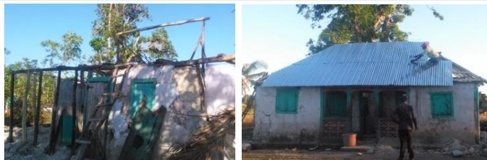
La maison d'Enise avant et après réparation
