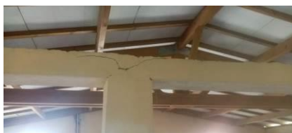
Grande salle : poutre intermédiaire.
